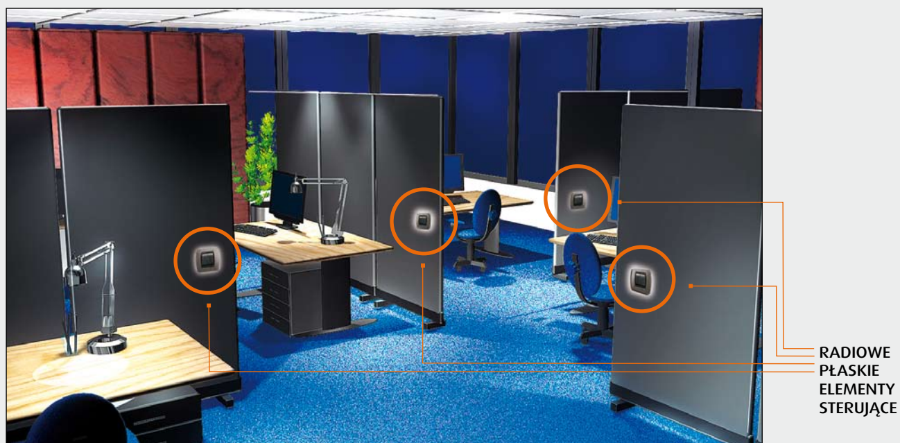
Zastosowanie radiowych elementów sterujących w pomieszczeniach z ruchomymi ściankami działowymi.
