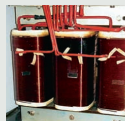
Termografia na podczерwień wykrywa przegrzanie cewek transformatora spowodowane niesymetrycznymi obciążeniami.
