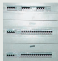
Przy użyciu podczерwień nie można sprawdzić temperatur okablowania i połączeń bez wcześniejszego zdemontowania osłon. Metoda ta umożliwia szybkie wykrycie uszkodzonego lub przeciążonego aparatu.
