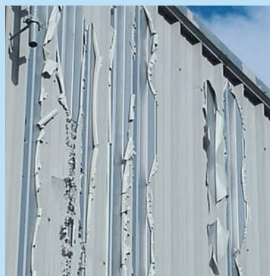
Typowe odklejenie się warstw farby na powierzchni galwanizowanej.
