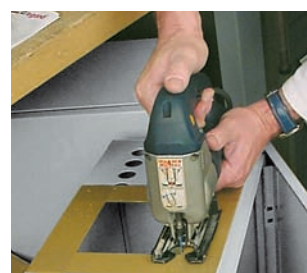
^ Wycinanie wyrzynarką otworów w szafce Atlantic, z uprzednim zabezpieczeniem jej taśmą klejącą.
