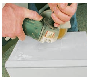
^ Wycinanie piłą diamentową otworów w szafce Marina.
