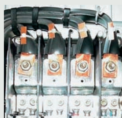
Zdjęcia umożliwiają szybkie rozpoznanie sprawdzanego miejsca lub urządzenia. Widzimy tutaj, że należy zwiększyć rozstaw pomiędzy szynami elastycznymi.
