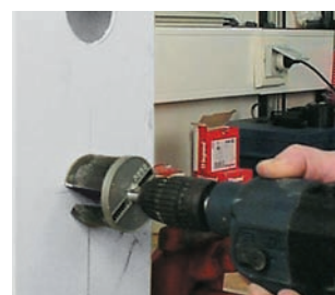
^ Wycinanie otwornicą otworów w szafce Marina.
