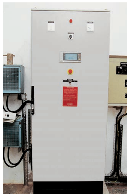
< Szafy Altis: przeznaczone do suchych i wilgotnych pomieszczeń przemysłowych.
